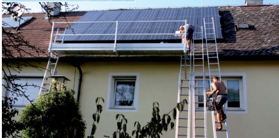
Die Montage der PV-Anlage bei Familie Bauer in Kronstorf
